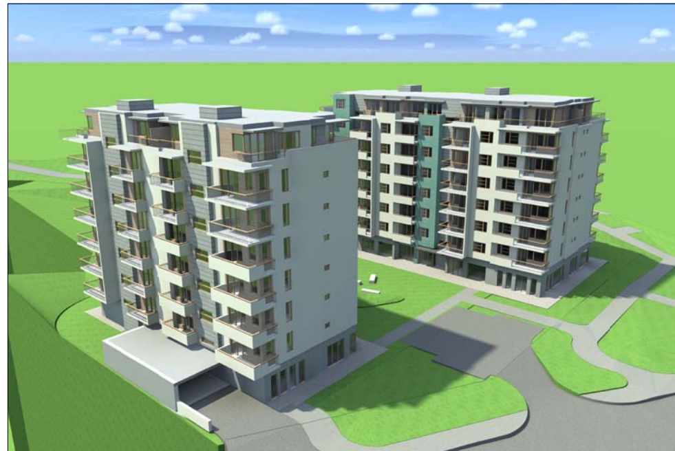
Pohled od SEVEROVÝCHODU
